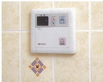
キッチンのオートバス操作パネル／お風呂の準備がキッチンでもできます。給湯、自動保温、追い焚きなどの操作がワンタッチ。
