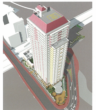
屋上に設けたヘリコプター用ホバーリングスペース。
