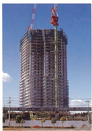
●工事中のウエストタワー
